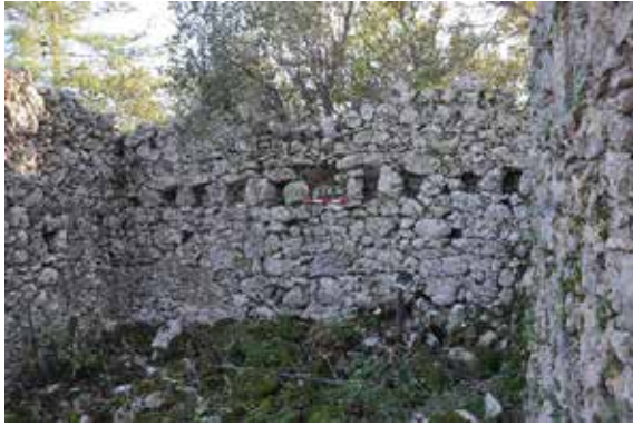
Fig. 7. Güneydoğu Yerleşim Batısı İki Katlı Yapı
