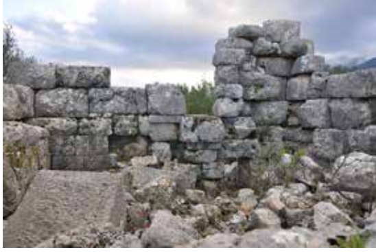
Fig. 14. Güneydoğu Kule Çiftlik İç Duvar, Kapı ve Pencere
